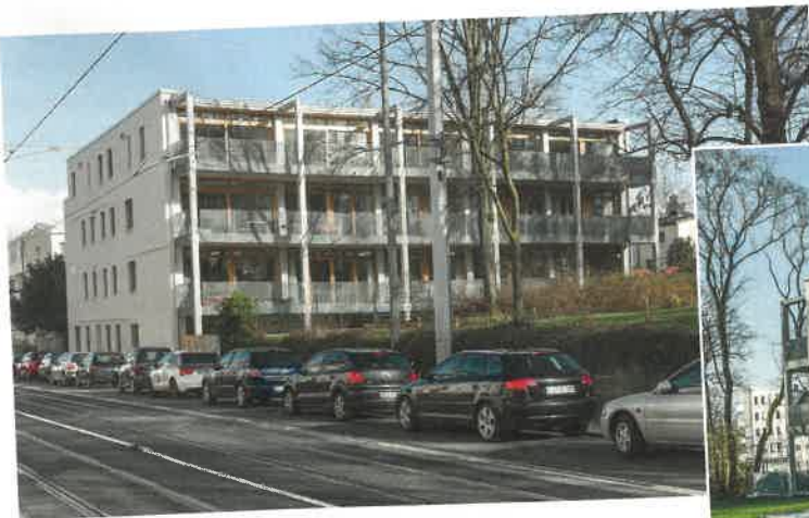
7 Die Erschließung erfolgt über sehr breite Laubengänge – hier trifft man sich gerne zu einem Plausch, was der Hausgemeinschaft zugute kommt. Im K76 wohnt niemand so ganz allein.
